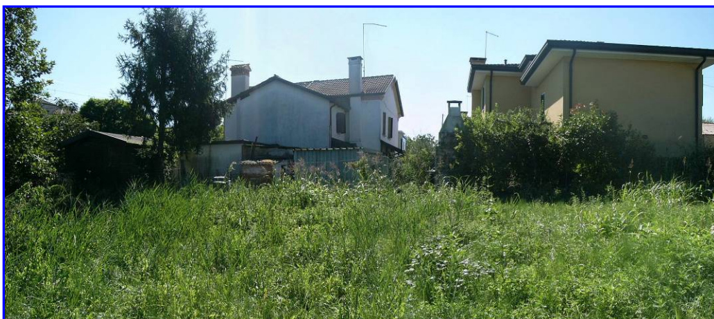
Vista degli edifici confinanti con l'area da urbanizzare.
